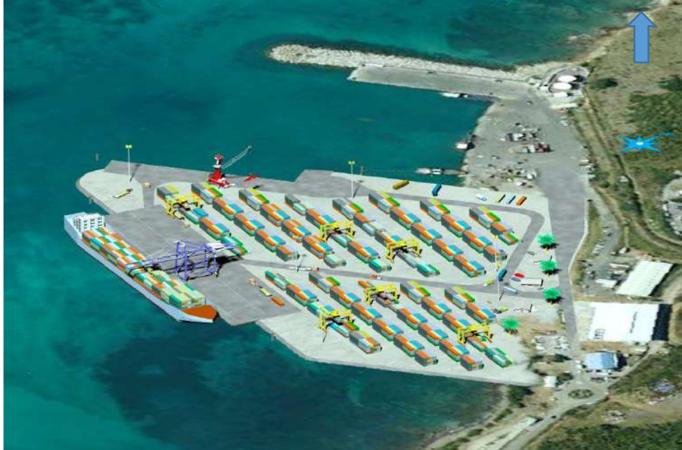
C/ Vue du Port de Galisbay à Saint-Martin après les travaux d'extension
